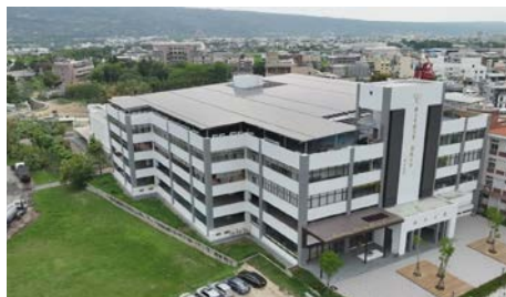
▲南投分部綜合大樓屋頂的太陽能板
