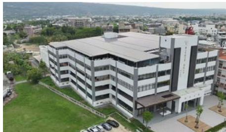
▲南投分部綜合大樓屋頂的太陽能板
