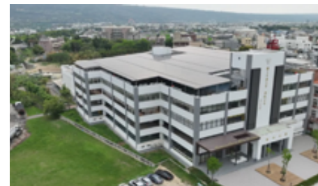
▲南投分部綜合大樓屋頂的太陽能板
