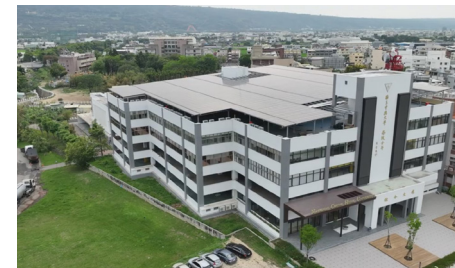
▲南投分部綜合大樓屋頂的太陽能板
