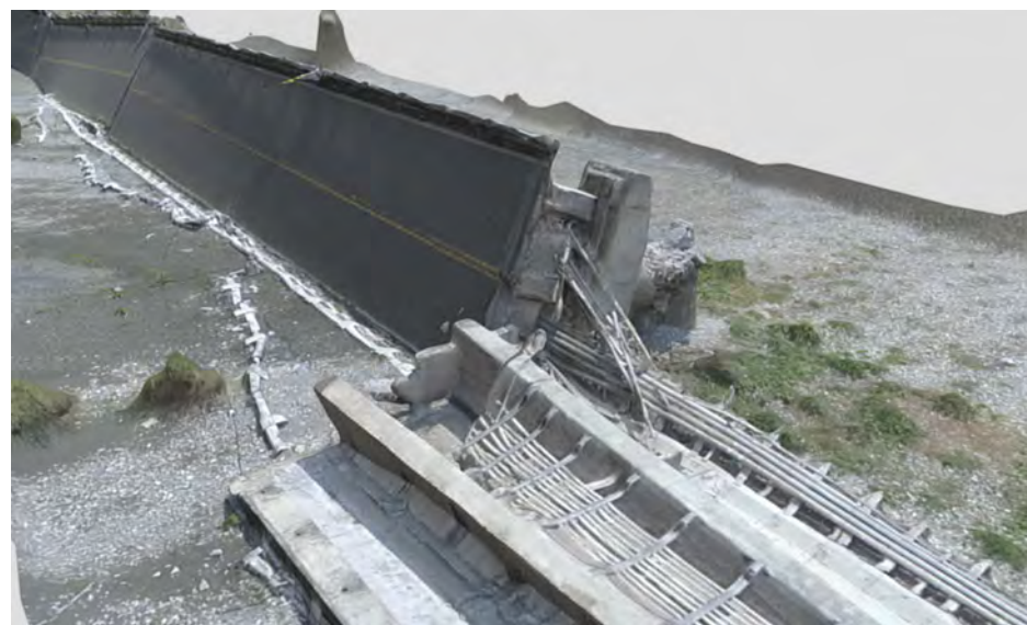
▲ 興大建置高寮大橋現場環景 3D 模型
