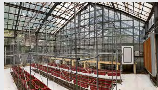
▲舊有溫室改建成智能溫室其內部設有環境控制主控箱、監控系統、灌溉系統、感測器、風扇及水牆
