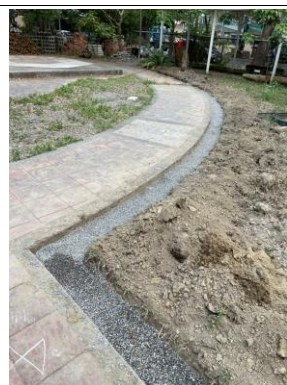
圖 23 排水系統完工
