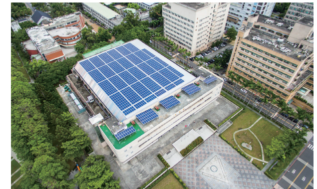
▲ 惠蓀堂屋頂太陽能光電發電設備
